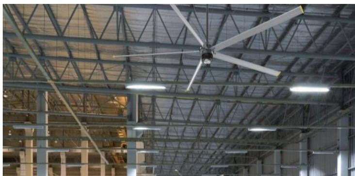
HVLSファンは空間全体の空気をかき混ぜることにより嫌なにおいの煙、湿気などを効率よく分散させ、室内の空気の質を改善し、健康で快適、安全な作業環境を実現させます。
